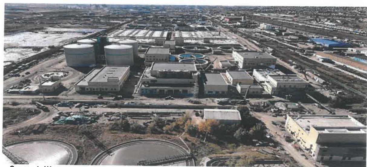
Зураг 4. Шинэ төв цэвэрлэх байгууламжийн барилга угсралтын ажлын явц 2024.9.28-ны байдлаар
